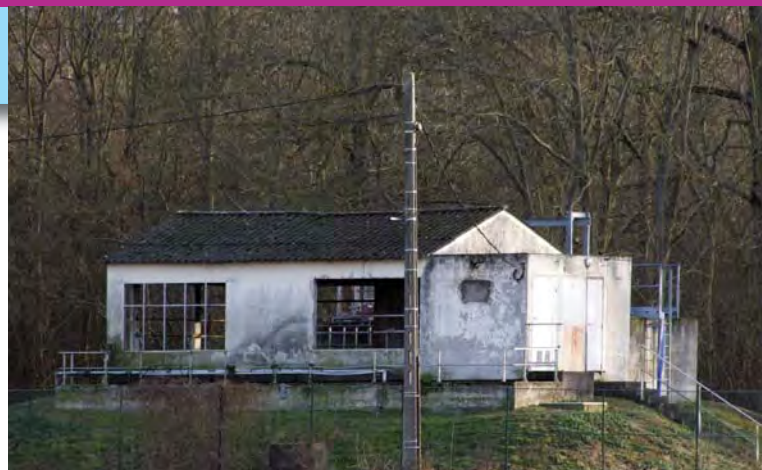
La station d'épuration de Trilport
