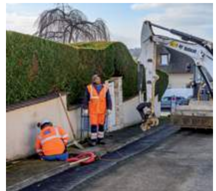
Enfouissement du réseau d'alimentation de l'éclairage public
