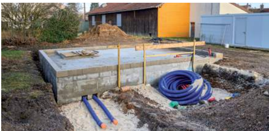
Construction de la chaufferie du réseau de chaleur
